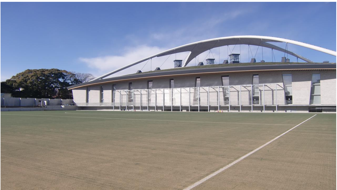
【写真1】駒沢第1球技場 サンドベースのショートパイル人工芝が敷設されている。 ラインは埋め込みで、白線がホッケー、青線がサッカーである。 屋内球技場の手前にあるのはアーチェリー用の防矢ネット設置架台である。
